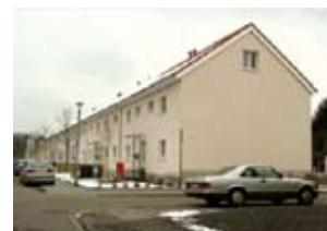
Petit résidentiel de 24 appartements réhabilités. Dans le cadre du programme «EnSan», les consommations de chauffage ont été divisées par plus de 8 et s'élèvent après rénovation à 23 kWh/m 2 par an.
