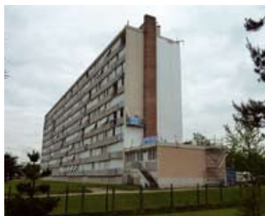
Copropriété « Le Soleil » : travaux d'isolation extérieure sur un des pignons
