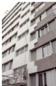
Aspect d'une façade en cours de travaux : à gauche, la partie isolée, à droite, l'état initial.
